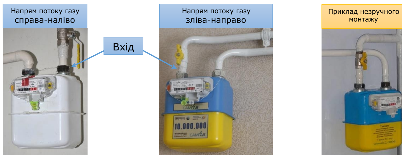
Рис. 8 Приклади монтажу лічильників газу
